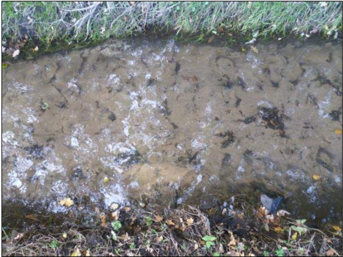
Abb. 14: Vollständig versandete Gewässersohle im ausgebauten Abschnitt der Ellenbäke (Foto: J. Kiefer)
